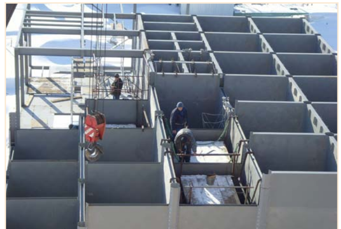
Монтаж силосного корпуса
